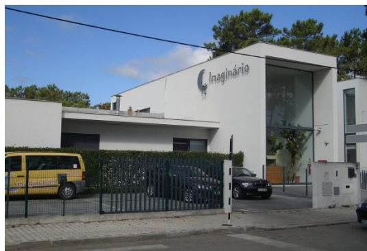
Fotografia 4.15 – Colégio “Imaginário” (Local 15)
